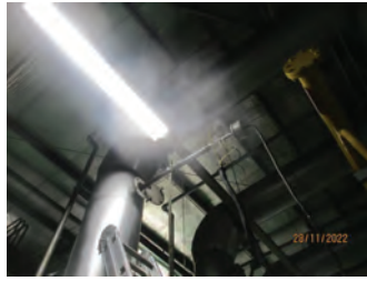
รูปที่ 6 ปล่อง Boiler No.5 Parameter : TSP, SO 2 , NO x , CO
