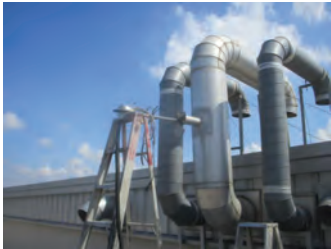
รูปที่ 7 ปล่อง Out Feed Fryer No.2 Parameter : TSP, Oil Mist
