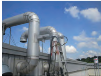
รูปที่ 8 ปล่อง In Feed Fryer No.2 Parameter : TSP, Oil Mist
