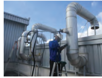
รูปที่ 9 ปล่อง In Feed Fryer No.3/1 Parameter : TSP, Oil Mist
