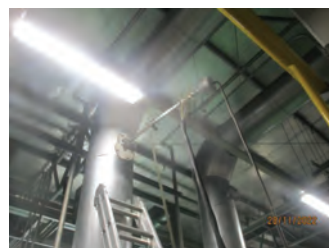
รูปที่ 3 ปล่อง Boiler No.2 Parameter : TSP, SO 2 , NO x , CO
