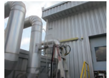
รูปที่ 12 ปล่อง Out Feed Fryer No.3/2 Parameter : TSP, Oil Mist
